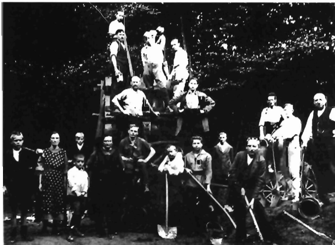
Bei den Bauarbeiten am Denkmal
