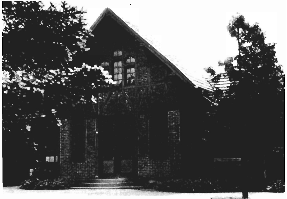
Die alte Leichenhalle, erbaut 1906 – 1907
