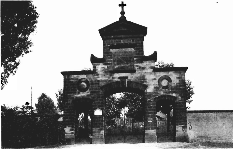
Der Haupteingang des „Am Jungenwald“ 1901 neu angelegten Friedhofes erhielt eine aufwendig gestaltete Toranlage.
