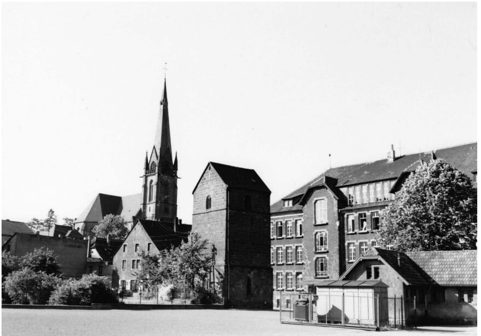
Bild 14: evangelische Kirche, Alter Turm, Teil des Turmschulhauses, Toilettenanlage
