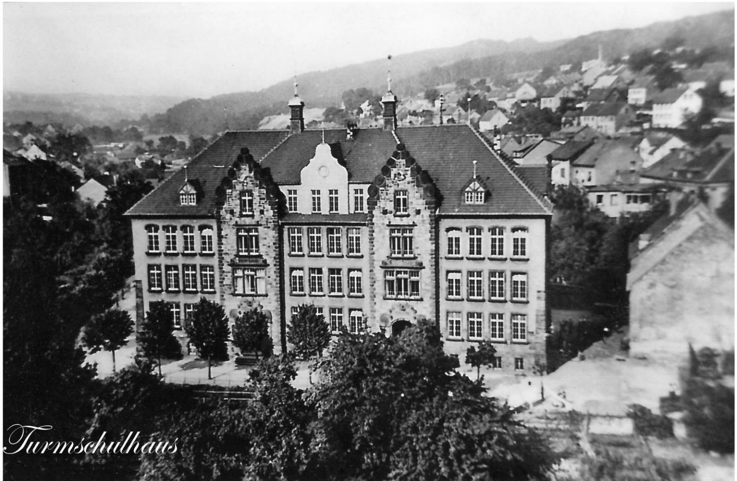
Bild 1: Turmschulhaus im ursprünglichen Zustand – Alte Postkarte 1930er Jahre
