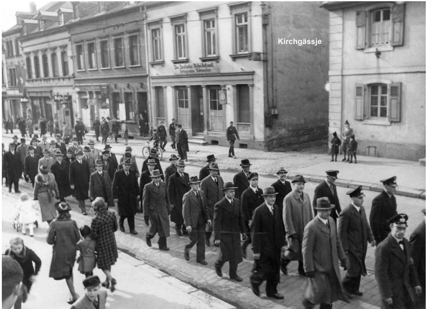
Bild 2: Zugang zur Turmschule auf der gegenüberliegenden Straßenseite – um 1940
